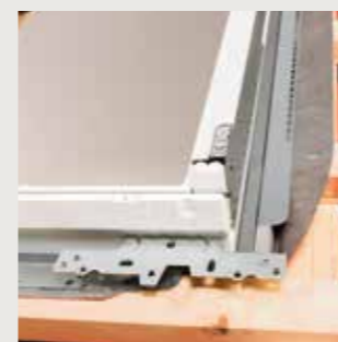
Теплоізоляційний контур надійно утеплює периметр вікна
